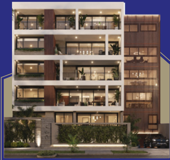
EDIFICIO 460 NICOLÁS DE RIBERA
