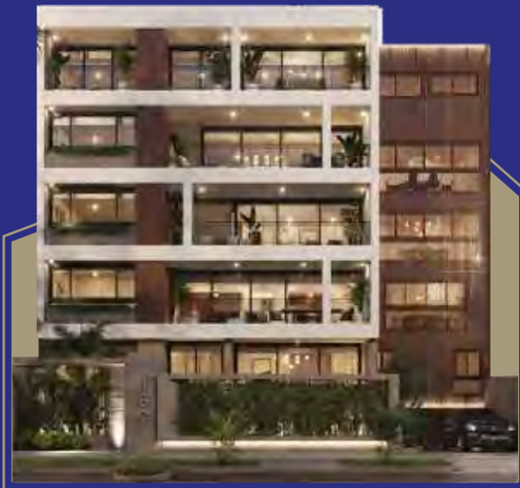
EDIFICIO 460 NICOLÁS DE RIBERA
