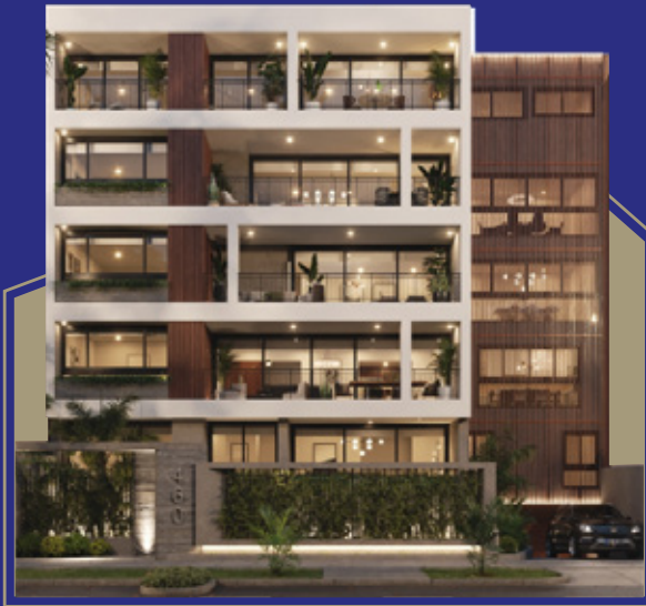
EDIFICIO 460 NICOLÁS DE RIBERA
