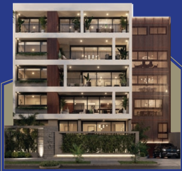
EDIFICIO 460 NICOLÁS DE RIBERA
